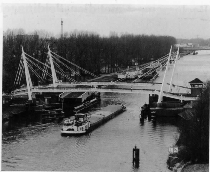
Behalve de mogelijkheid de brug draaibaar te maken, is ook het brugdek één meter te verhogen. Een vlak deel van het dek wordt dan vervangen door een hellend deel.
