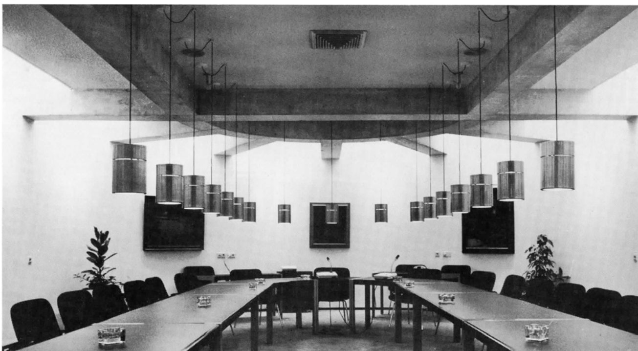
In de raadzaal komen de betonbalken van de hal samen.
