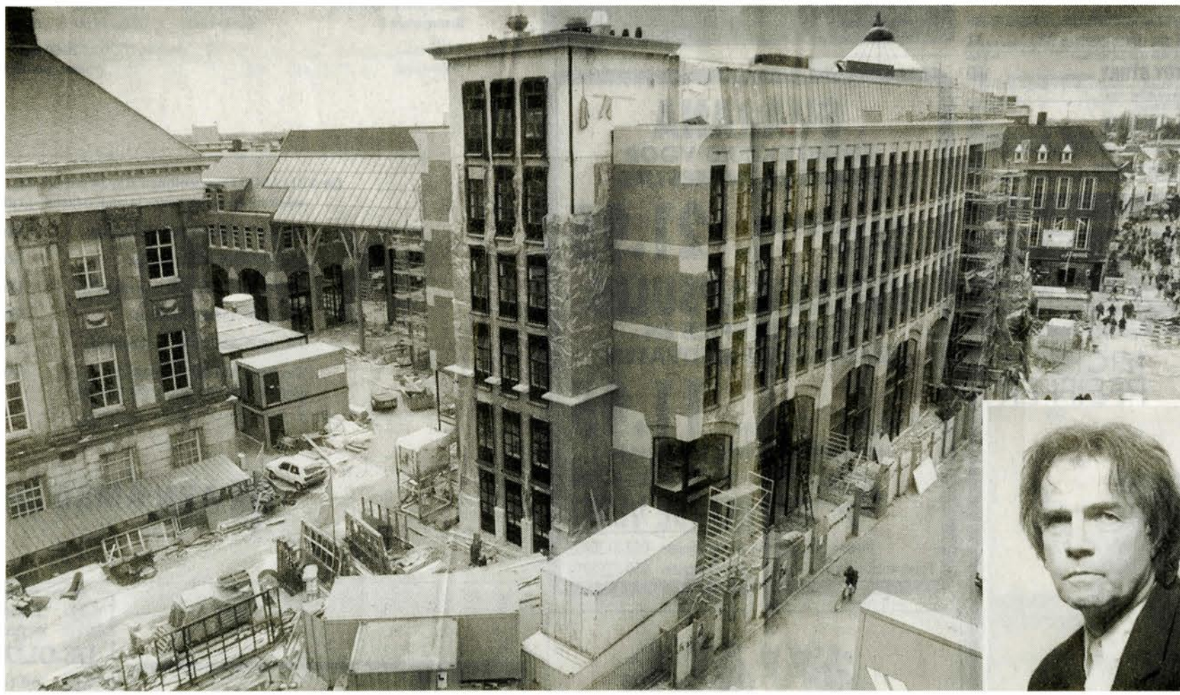
– Co-architect Cor Kalfsbeek (inzet) bekritiseert de vele onnederlandse 'gouden deurknoppen', die Natalini in de Waagstraat heeft aangebracht, maar roemt het stedenbouwkundige concept.
