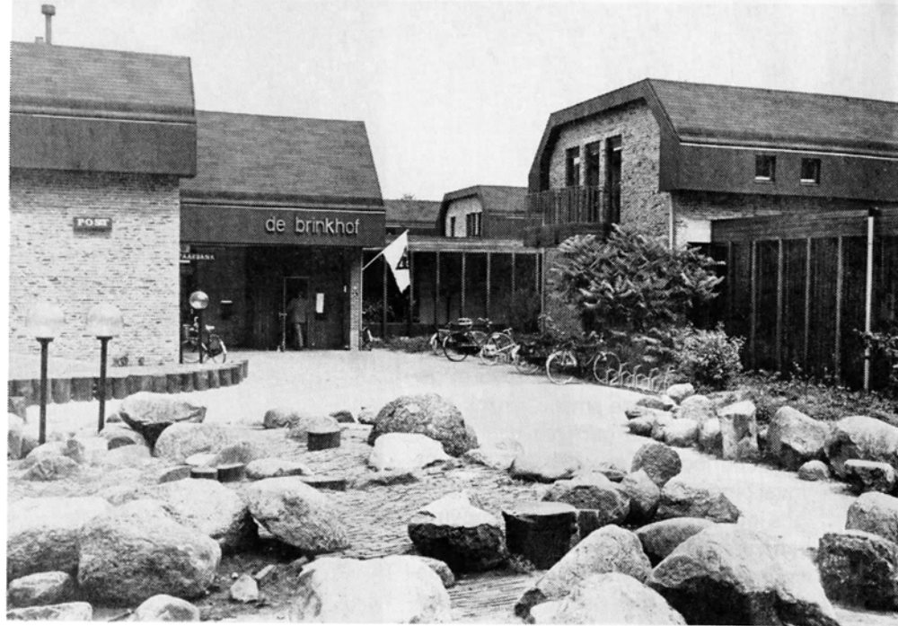
11. Hoofdentree van 'De Brinkhof' in Norg met geheel rechts de raadszaal en links het postkantoor.
