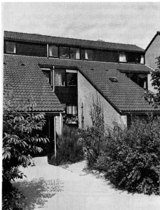
7. Detail van de woningen in Borger met de entree tussen de garages.
